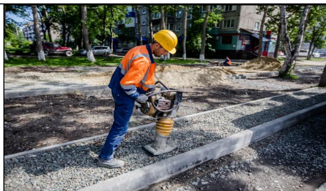
Устройство (ремонт) тротуаров
