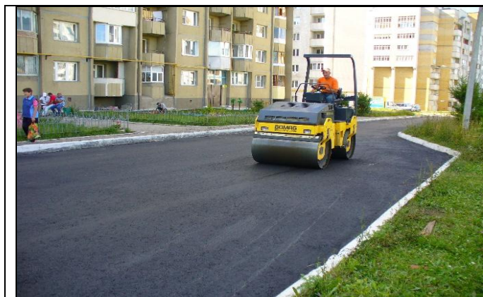
Асфальтирование дворовых проездов
