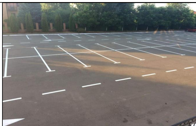
Устройство парковочных пространств
