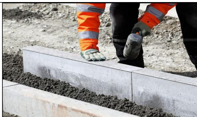
Установка или замена бордюрного камня
